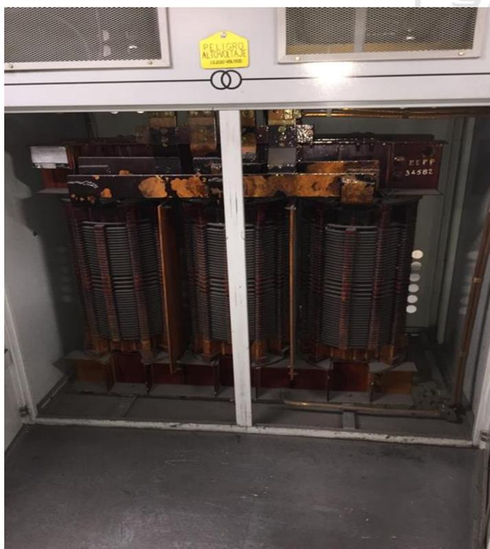
Figura 2. Transformador 750 KVA subestación 1.
