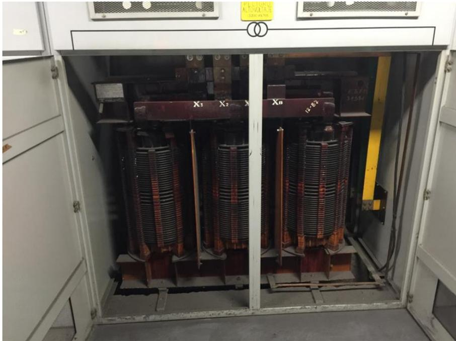
Figura 3. Transformador 750 KVA subestación 2.
