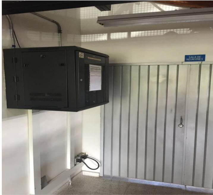
Figura 9. Rack de datos mal ubicado en la sede obreros de cobertura.
