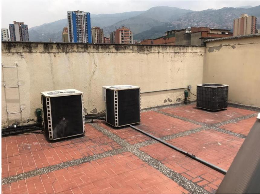
Figura 11. Unidades condensadoras para trasladar por impermeabilización de terraza en la sede escuela del maestro.
