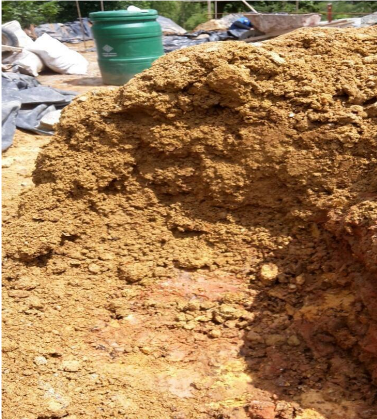
Ilustración 13. Registro del suelo entre los cinco y siete metros de excavación.
