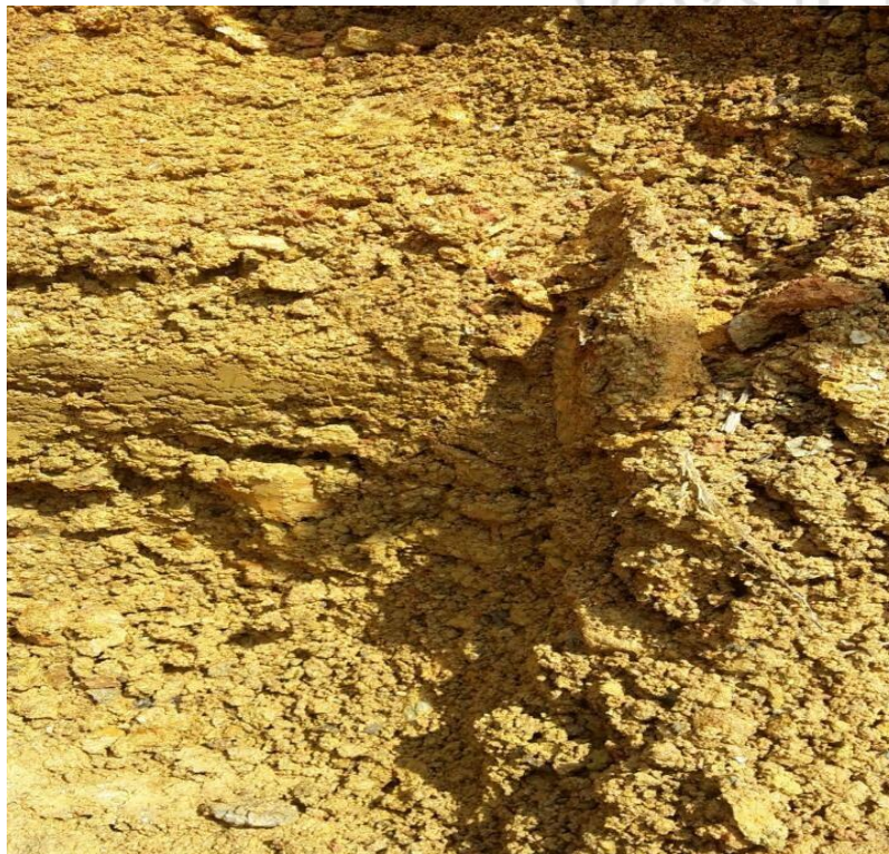
Ilustración 11. Registro del suelo en los dos primeros metros de excavación.
