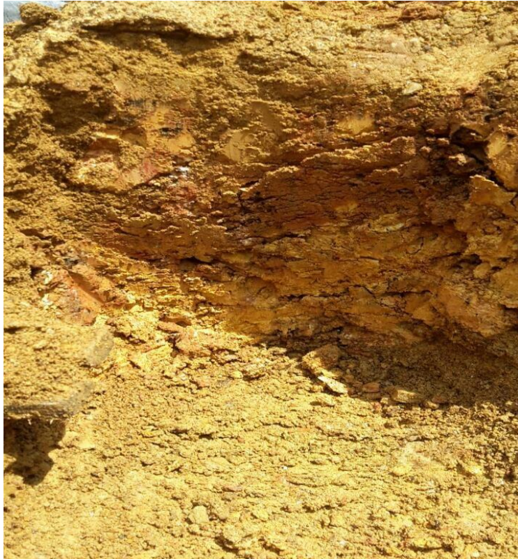
Ilustración 12. Registro del suelo entre los dos y cinco metros de excavación.
