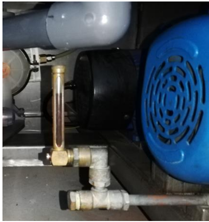
Imagen 20: Nivel aceite motorreductor Accelacota 2. Fuente: autor.
