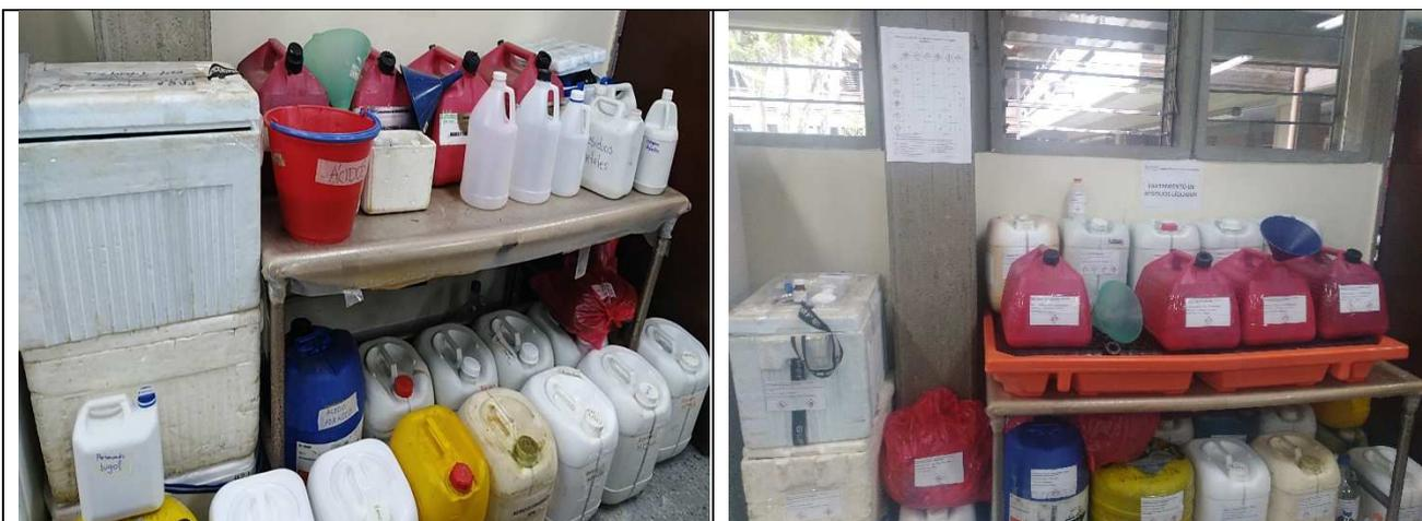
*Ilustración 16 Punto de almacenamiento de residuos peligrosos sólidos y líquidos antes y después de instalación de estibas antiderrame y etiquetado de recipientes*
