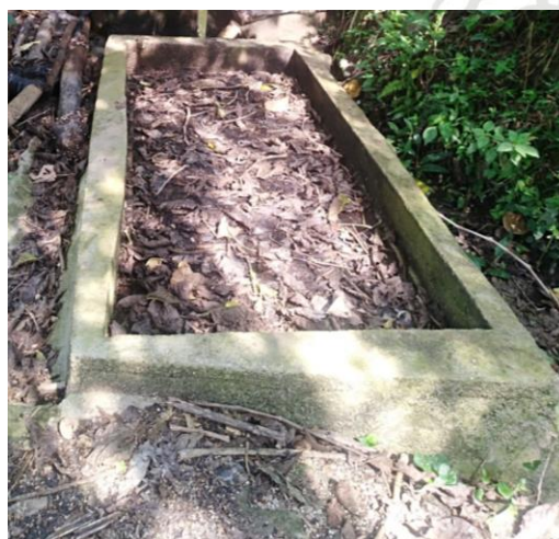
Figura 21: Estructura de desarenador para el sistema de captación por el método gravitacional. Fuente: [Obtención propia].
