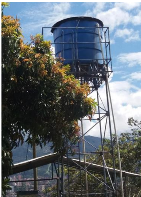
Figura 23: Estructura tanque elevado de almacenamiento antes de ser ingresado al sistema de tratamiento. Fuente: [Obtención propia].
