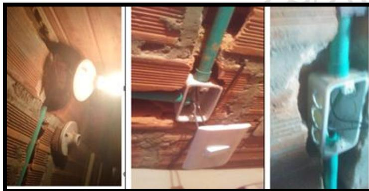
**Figura 22 Pieza 3 salidas , interruptor sencillo.**
