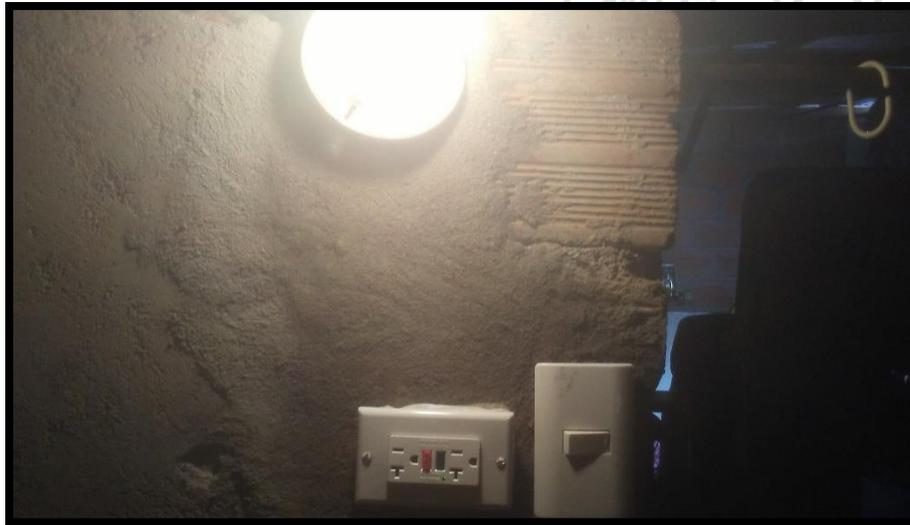
**Figura 43 Gfci e interruptor en baño.**
