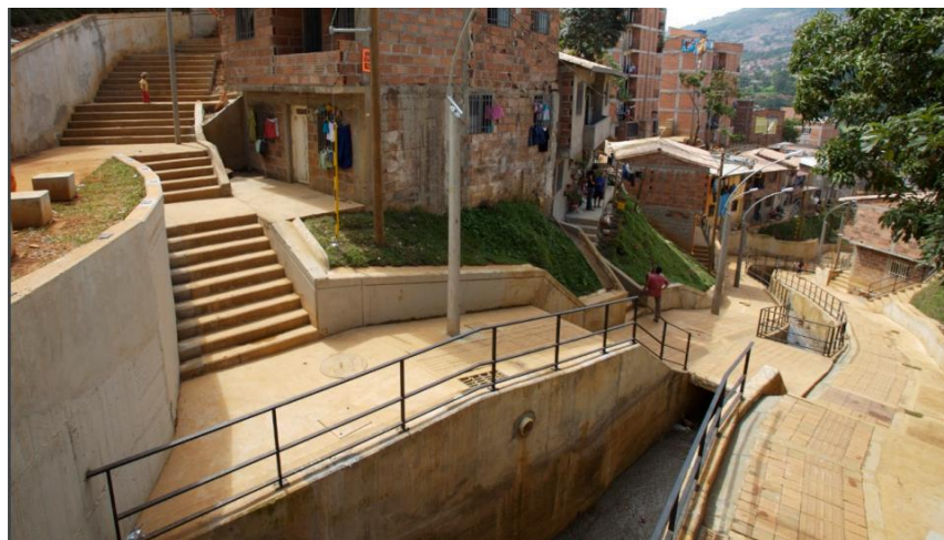
Figura 4. Consolidación habitacional y recuperación ambiental quebrada Juan Bobo.
