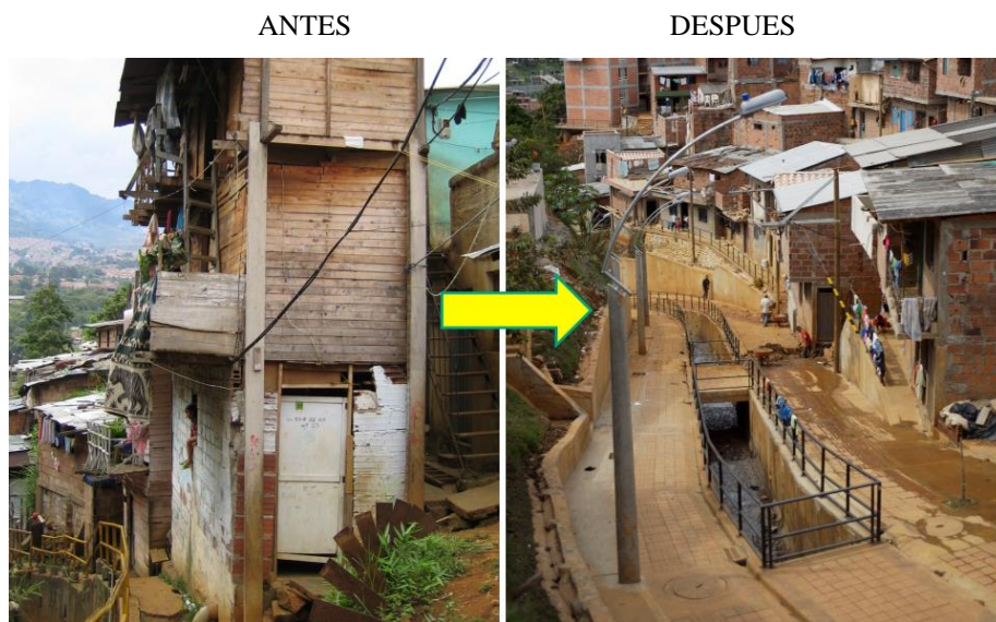
Figura 3. Consolidación habitacional y recuperación ambiental quebrada Juan Bobo
