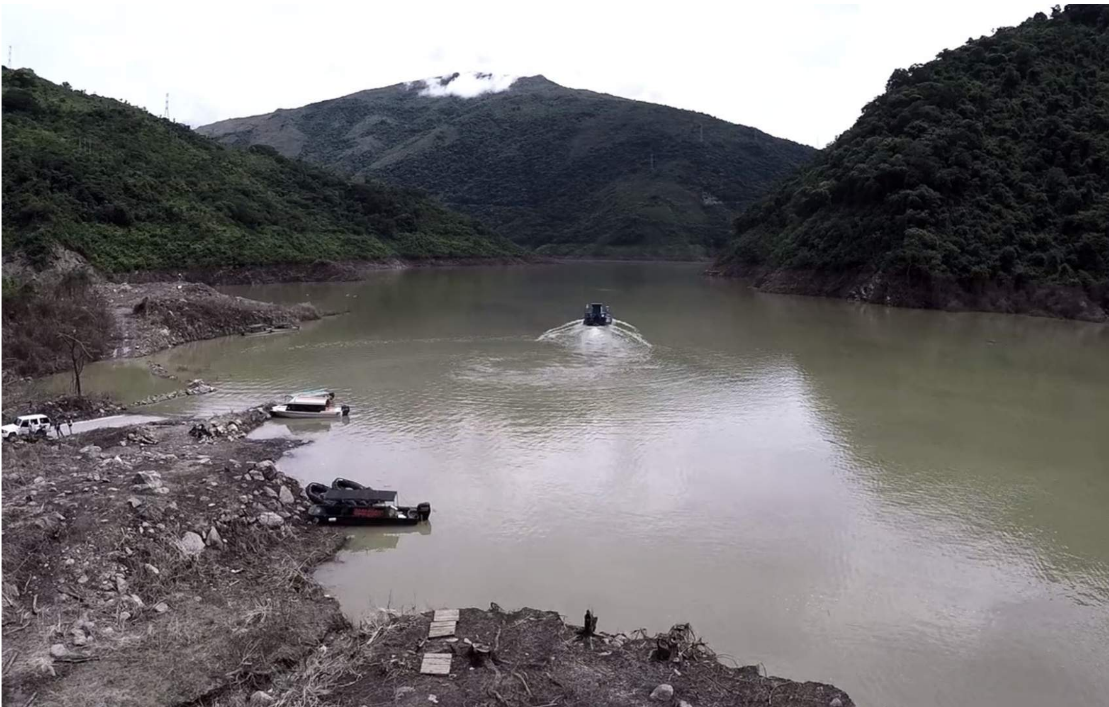
Otro de los aspectos que caracterizan a los archivos oficiales es la narración cronológica de los hechos: Memorias de Pescadero inicia con fotografías históricas y termina con imágenes actuales como esta, la del embalse que hoy inunda al puente y estanca al río.
