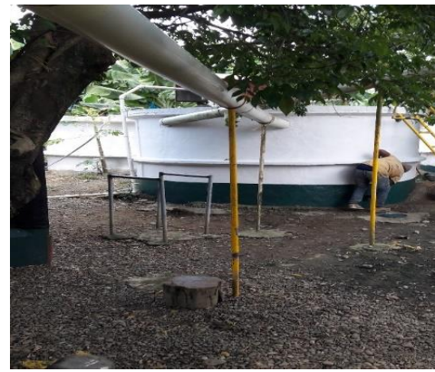
Fotografía 84. Pintura general tanques de agua lluvia.
