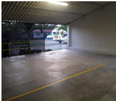
Fotografía 83. Señalización rutas y demarcación real palletizado.
