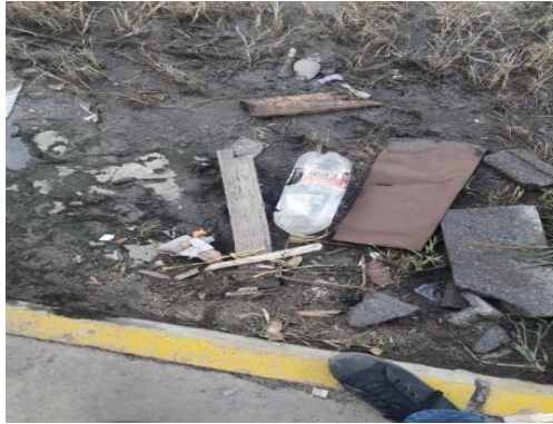
Fotografía 9. Residuos sólidos en campo.
