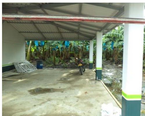
Fotografía 1. Patio de materia orgánica desordenado y usado como parqueadero.
