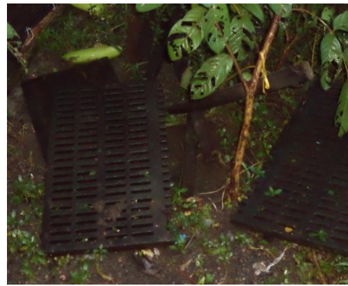
Fotografía 18. Rejillas plásticas mal-ubicadas.
