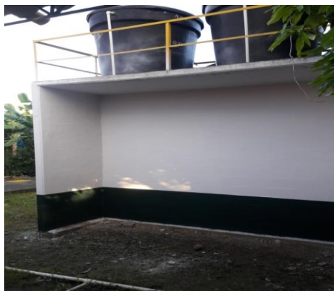
Fotografía 85. Pintura general bases de tanques elevados.
