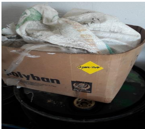
Fotografía 23. Área planta eléctrica con elementos de otras áreas.
