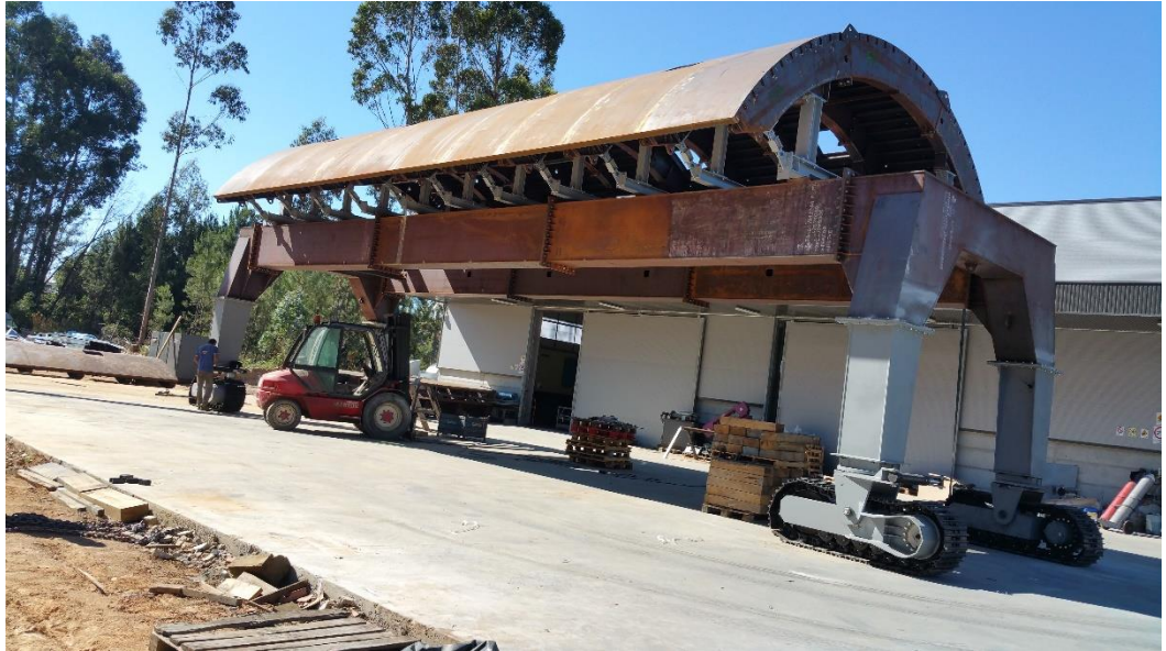
Ilustración 16. Carro porta encofrado 2
