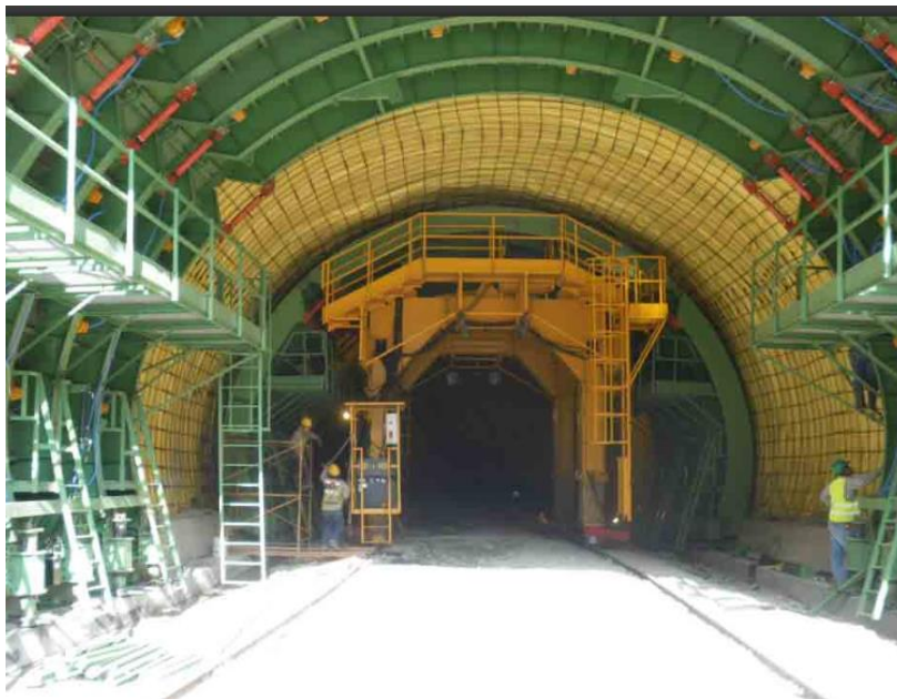
Ilustración 13. Ejemplo 4 de carro de encofrado. Tomada de https://rubricaingenieria.com/es/rubrica-proyecto/tuneles-de-cisneros-loboquerrero-colombia/
