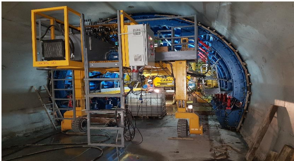
Ilustración 21. Carro encofrado para galerías 2
