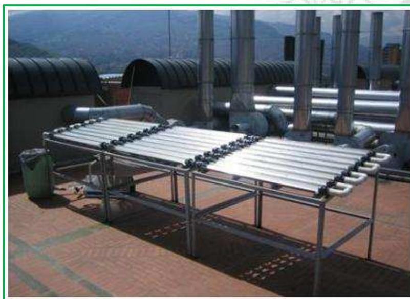
Figura 27 Colector solar empleado en este trabajo (Fuente: propia).
