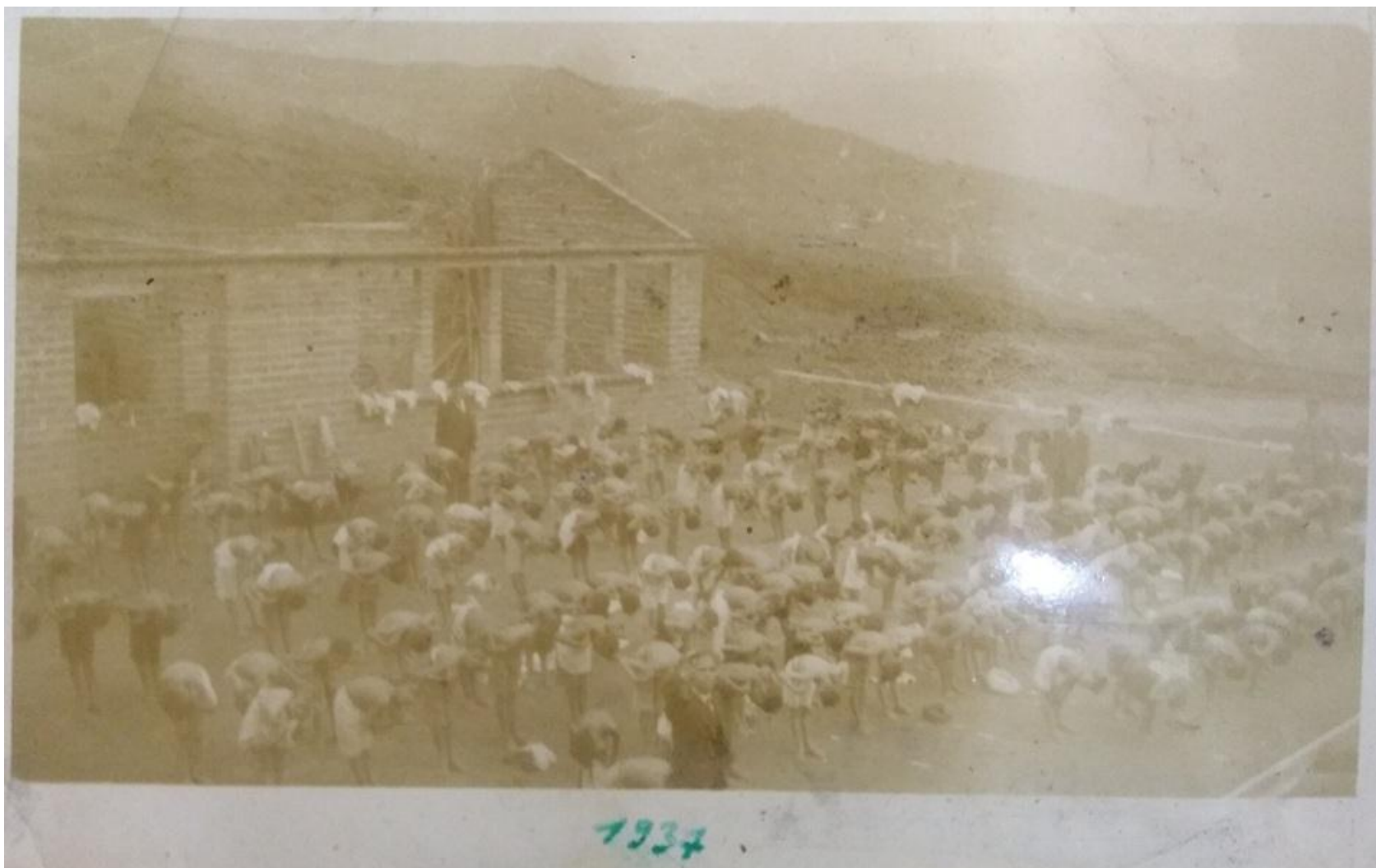
Figura 7. Construcción de la escuela Anexa Santander 1937.
