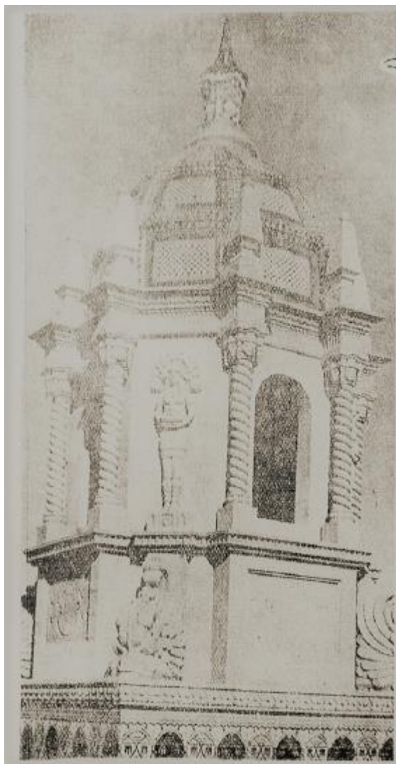
Ilustración 2 Una de las torres del pabellón de Sevilla. Universidad , 31 agosto, 1929, no 149.
