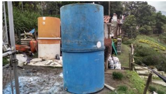
Imagen 24. Construcción de los reactores metanogénicos
