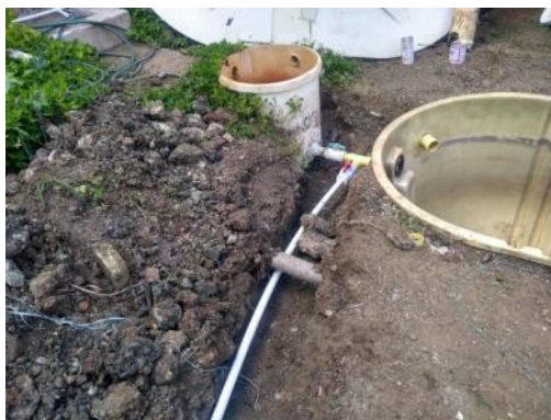
Imagen 27. Adecuación tubería en el tanque de almacenamiento de efluente
