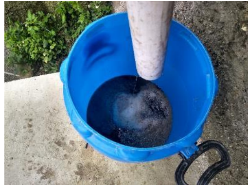
Imagen 21. Entrada de percolado al tanque pulmón
