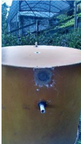
Imagen 25. Adecuación entrada de percolado y salida de biogás en los reactores metanogénicos
