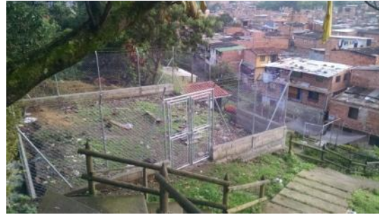
Imagen 13. Zona de picado y ubicación de reactores de hidrólisis
