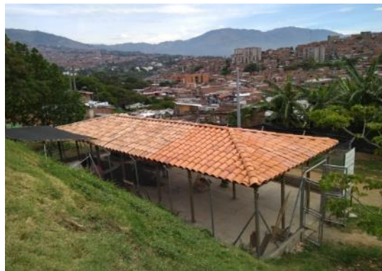
Imagen 11. Centro de recepción de material orgánico - Compostera
