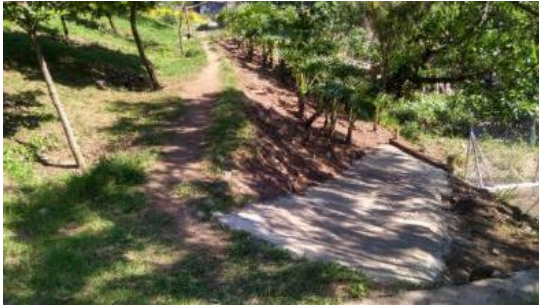
Imagen 12. Adecuación de caminos carreteables
