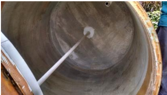
Imagen 23. Adecuación interior de los reactores metanogénicos
