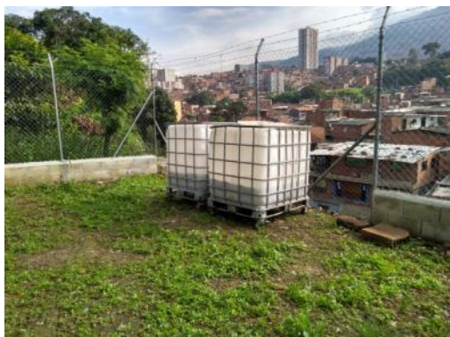
Imagen 16. Adecuación e instalación de los reactores de hidrólisis
