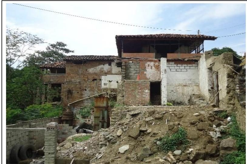
FOTO 4: diferentes materiales empleados en Liborina, Fachada en Tapias y materiales modernos en ampliaciones.
