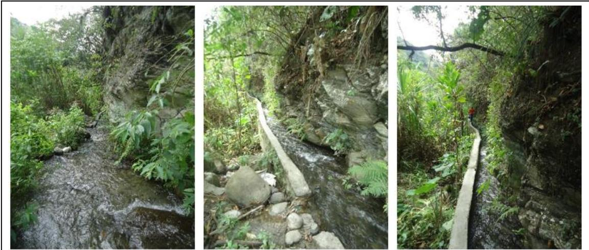
**FOTO 24 : Union del tramo a la canalizacion de cemento de la acequia.**
