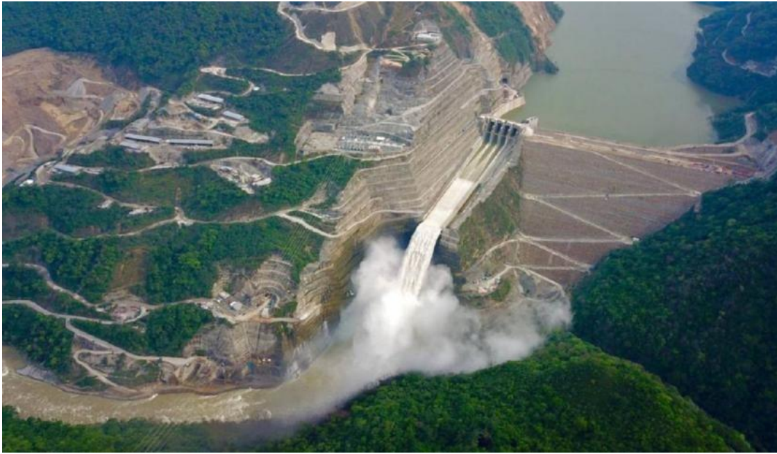
Ímágenes tomadas de https://www.eluniversal.com.co/colombia/anla-sanciona-a-hidroituango-por-obstruccion-a-la-quebrada-el-tenche-BD858056
