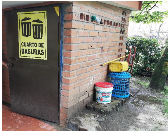
Figura 27. Sistema de ventilación de la Unidad Residencial Villas del Telar
