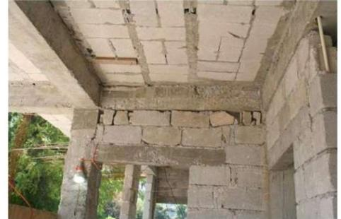
Hilada superior de mampostería sin contacto con la losa o viga superior.
