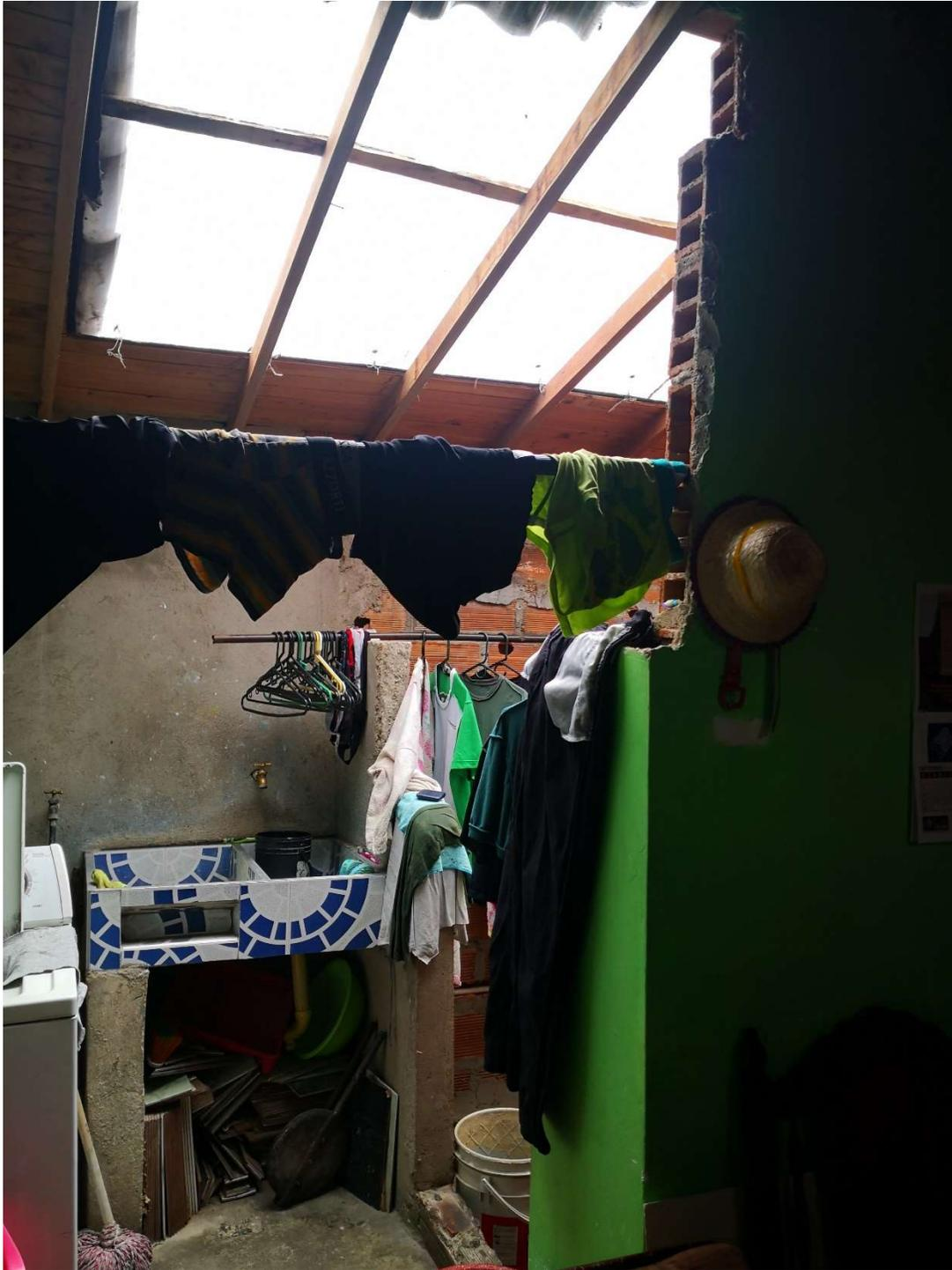
Evidencia fotográfica de la cubierta del patio en el Nivel 3 que no permite correcta ventilación en la vivienda. Fuente: elaboración propia
