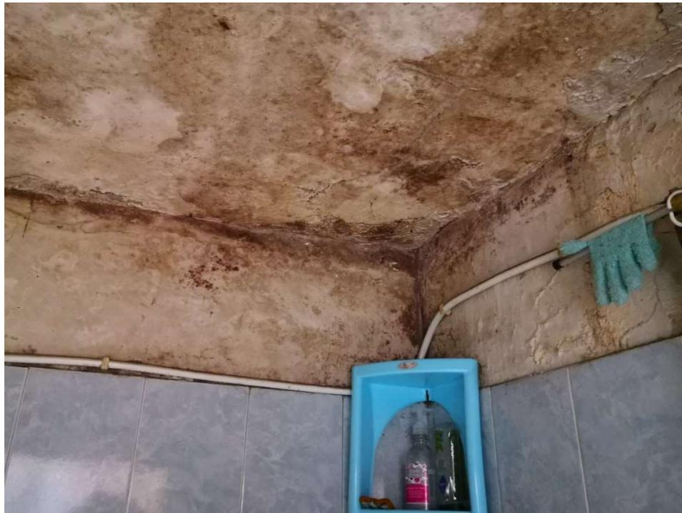
Evidencia fotográfica de problemas de humedad por localización de terreno en el muro posterior de la edificación Nivel 2. Fuente: elaboración propia
