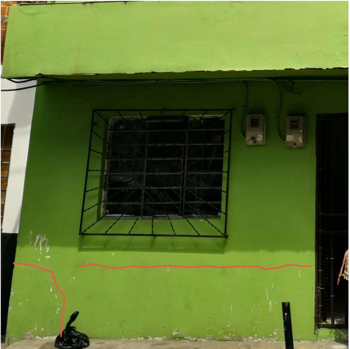
Evidencia fotográfica de fisura en el muro de la fachada del Nivel 1 y asentamiento en la esquina inferior izquierda del muro. Fuente: elaboración propia
