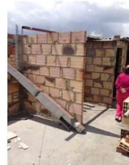
Obra en ejecución que muestra detalles mal hechos
