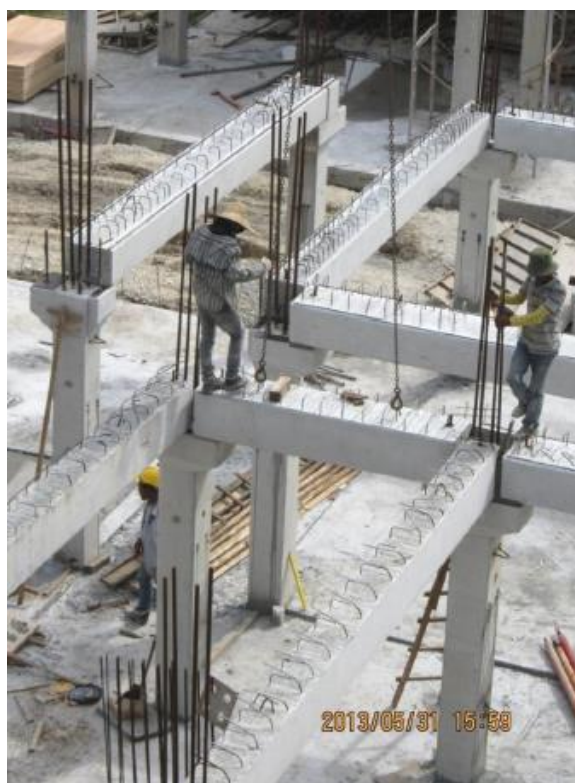
Figura 5. Procedimiento de izaje en obra (JAYA,K. 2016. Connections in precast structures, Anna University)
