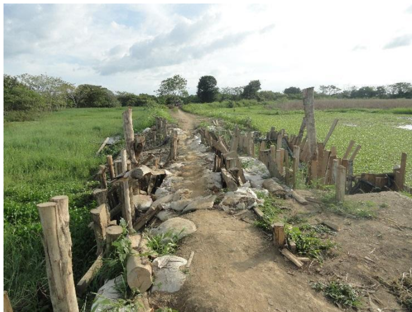
Imagen 32. El agua rompió este camellón. En: San Pablo-Cotorra. Foto por: Juan Camilo Rojas R; noviembre de 2017.
