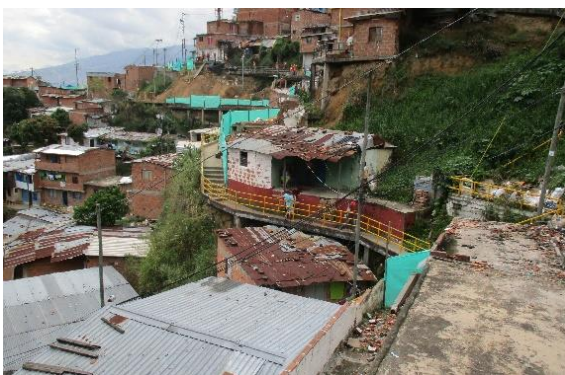
Figura 8 Viaducto media ladera tramo 2 Antes (s.f.) de la intervención (s.f). Fuente: Alcaldía de Medellín, Secretaría de Infraestructura Física.
