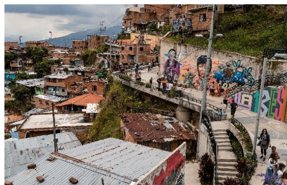
Figura 9 Viaducto media ladera tramo 2 después de la intervención (s.f). Fuente: Alcaldía de Medellín, Secretaría de Infraestructura Física.
