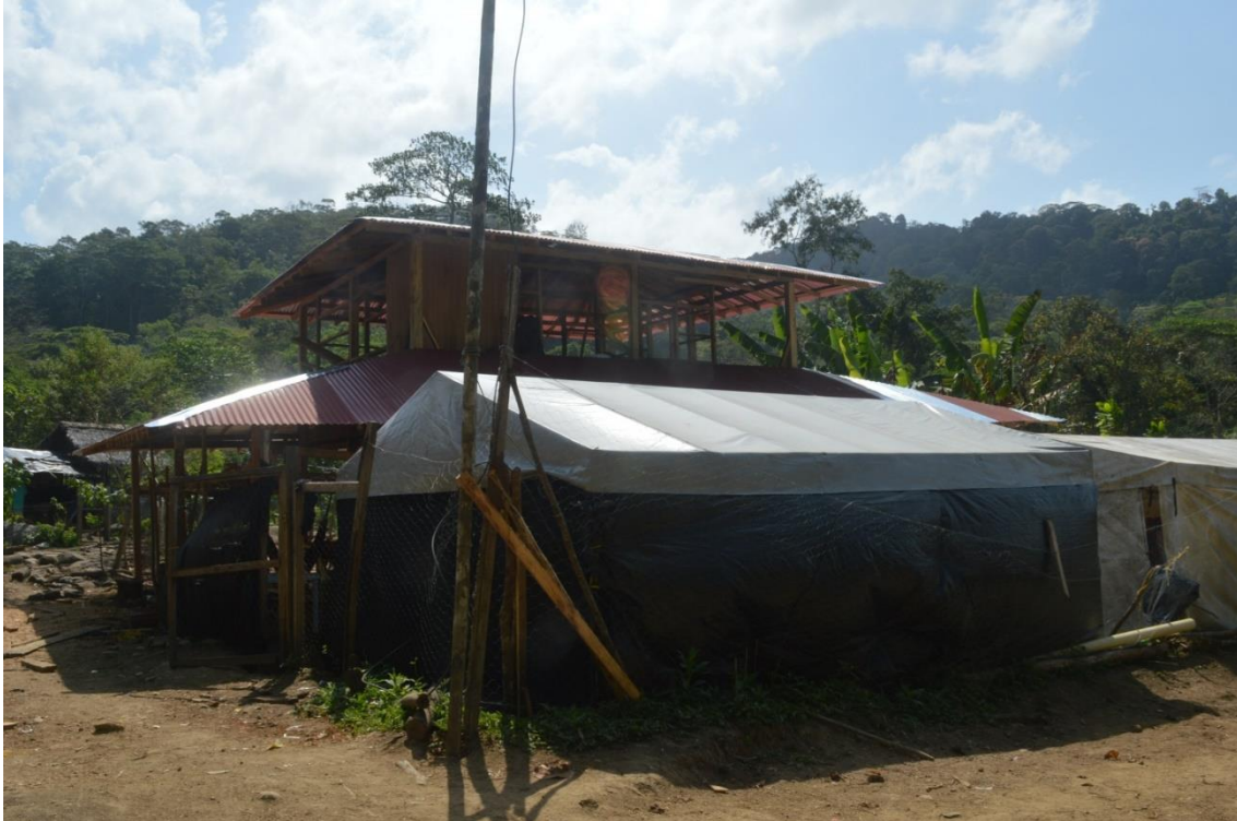
Ilustración III. Construcción de las casas. Mutatá, Ant. 2018. Fuente: Archivo personal.
