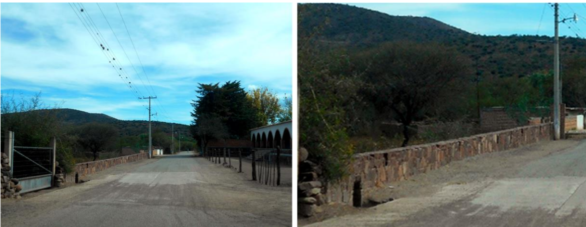
Imagen 12. Parte del camino “de abajo”, Hacienda Vieja, Tierra Nueva, San Luis Potosí, México.
