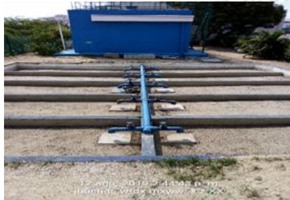
Ilustración 6. Lechos de secado
