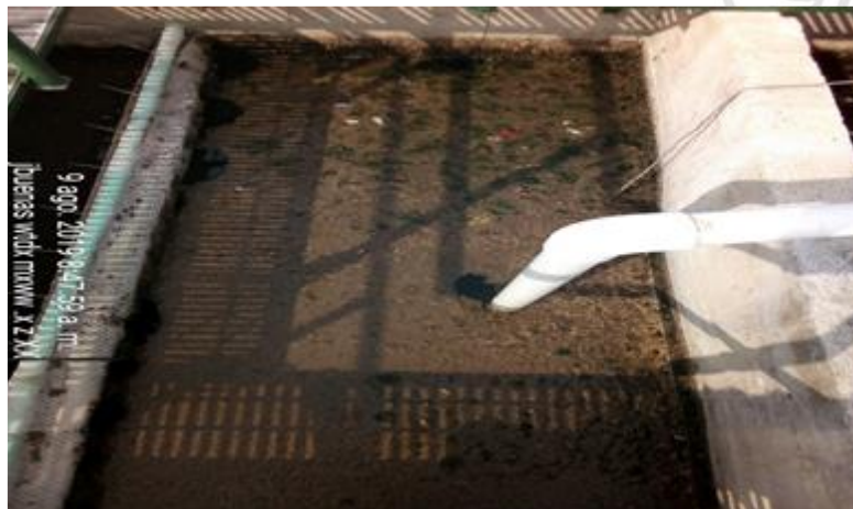
Ilustración 10. Natas en el sedimentador.
