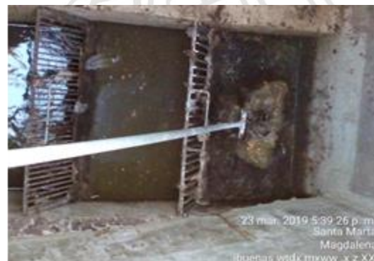
Ilustración 9. Estado de las cribas.
