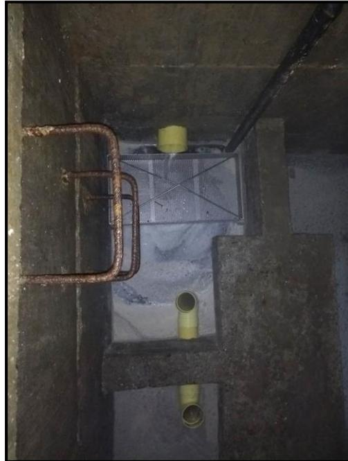
Figura 5. Trampa de grasas durante horario pico sin presentar igualación con el tanque siguiente.
