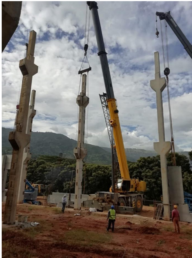
Figura 4. Aplome de columna mediante maniobras de grúa.
