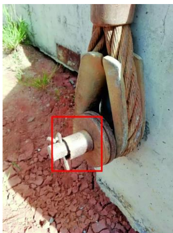
Figura 14. Implementación de seguro tubular en el eje de ménsula.
