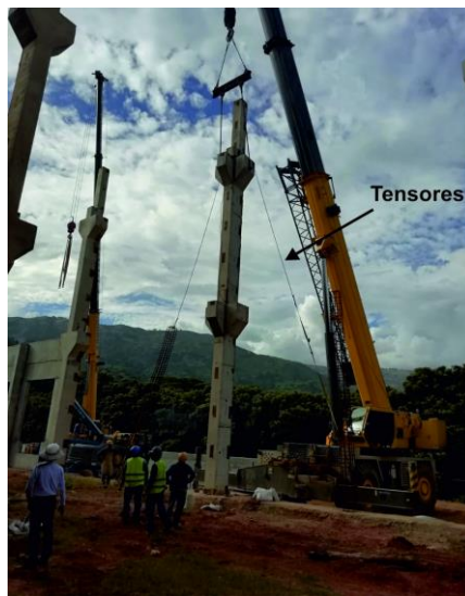
Figura 11. Aplome de columna mediante tensores
