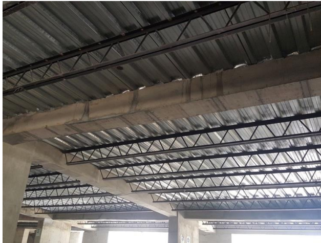
Ilustración 3. Vigüeta de alma abierta acción compuesta. (EspacioLeve Ingeniería, 2019a).
