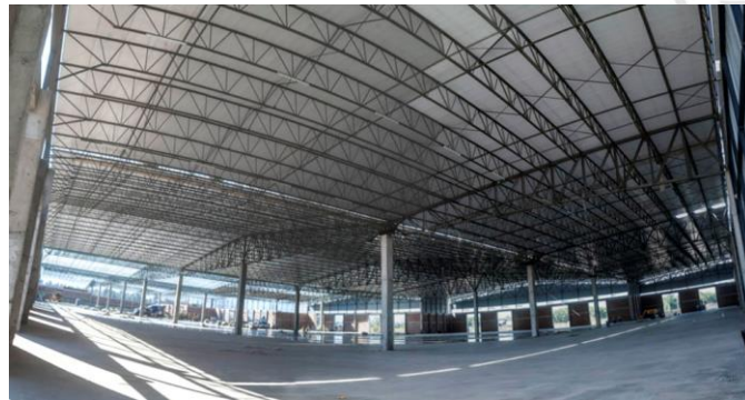
Ilustración 2. Vigueta de alma abierta para cubiertas. (Pfenniger y González, 2019).
