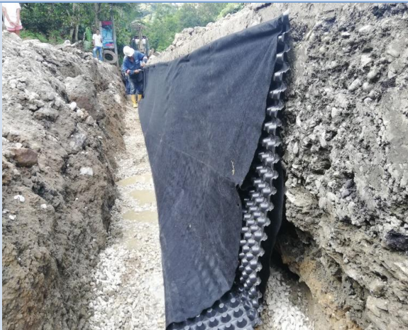
Ilustración 13. Instalación del geodrén en la zanja de drenaje.
