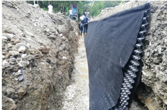
Ilustración 5. Lamidren L20DB como subdrenaje en vía.
