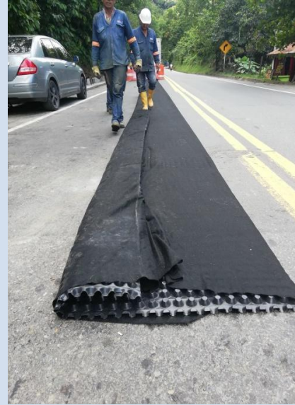
Ilustración 14. Preparación del geodrén Lamidren L20DB.
