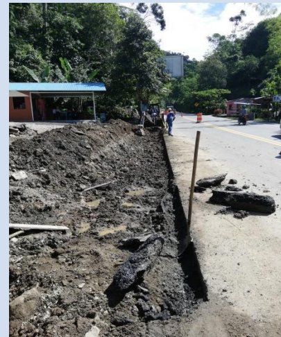
Ilustración 14. Llenado de la zanja del subdrén.
