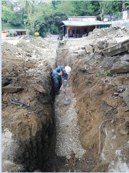
Ilustración 13. Excavación de la zanja longitudinal.
