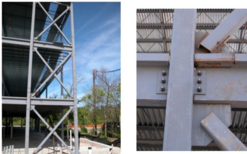
Ilustración 77. Conexión diagonal de contraventeo (riostras).
