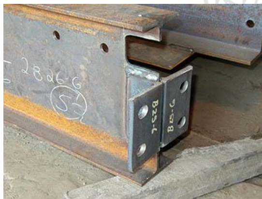
Ilustración 72. Conexión usando pernos y soldadura.
