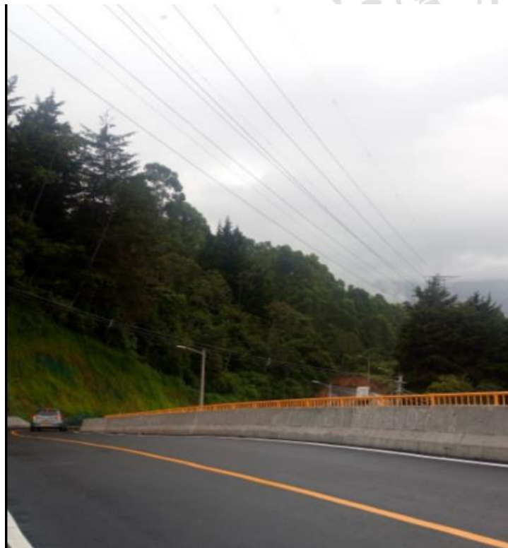
FIGURA 1. Visita en campo de proyecto, vía tramo 11 entre la calle 43
