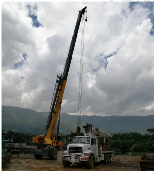
Fotografía 6. Grúa telescópica cargando muros en el camión para transportarlos hasta el acopio de prefabricados.
