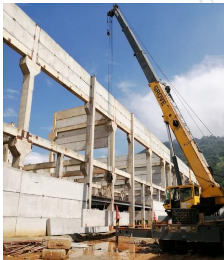
Fotografía 1. Grúa telescópica realizando un izaje.
