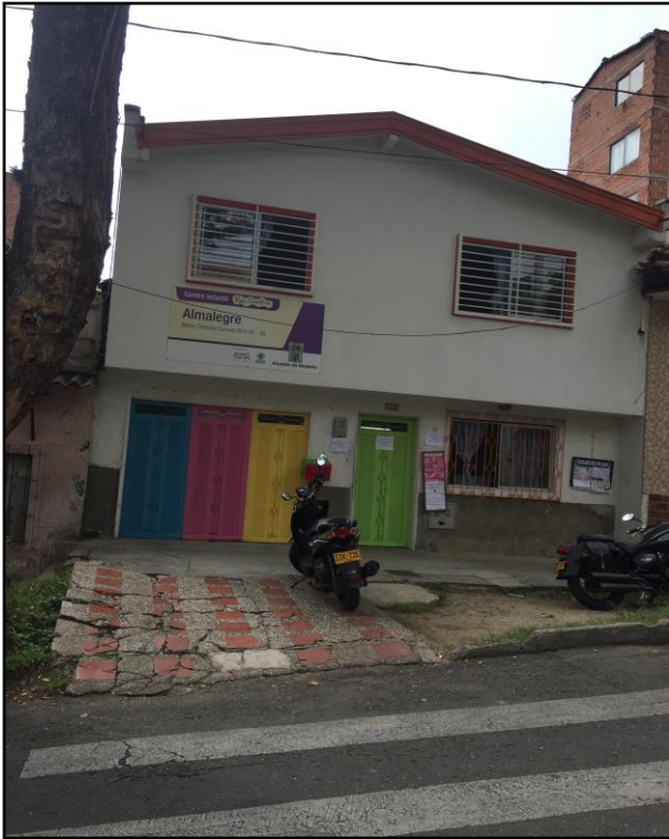
Ilustración 8: Centro Infantil Buen Comienzo Carrera 89 # 36-38 – Almaalegre- Barrio Cristóbal. Paso cebra en regular estado
