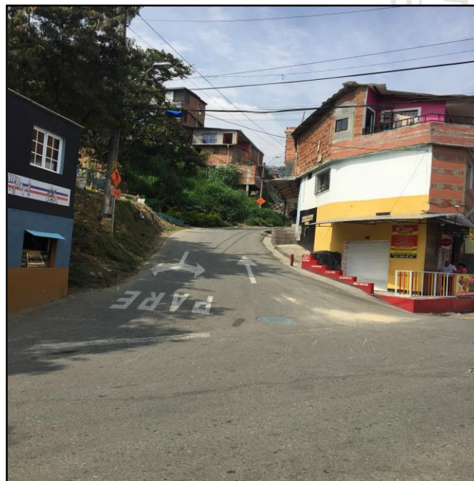
Ilustración 12: Calle 39D # 112-100. Sobre Calle 39C, ausencia de demarcaciones para la zona escolar. Vista hacia el sur
