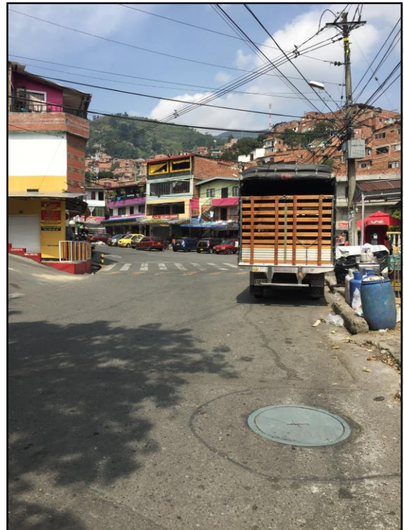
Ilustración 11: Calle 39D # 112-100. Reductor de velocidad mal demarcado y paso cebra en regular estado. Vista hacia el occidente.
