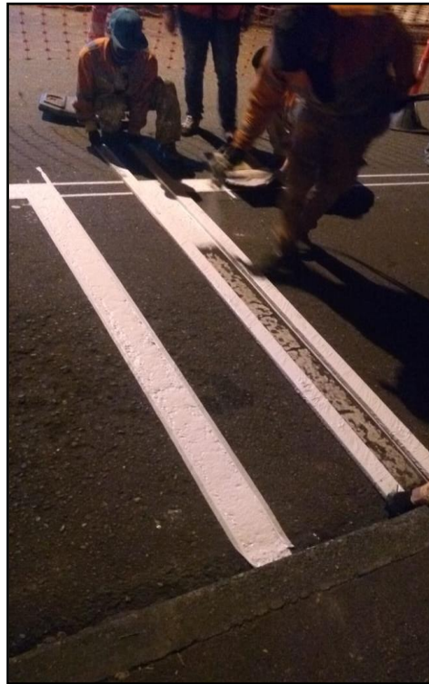
Ilustración 26: Cuadrilla realizando las actividades de demarcación de celdas y señalización horizontal sobre la Calle 8 entre carreras 35 y 36 el 11/04/2019
