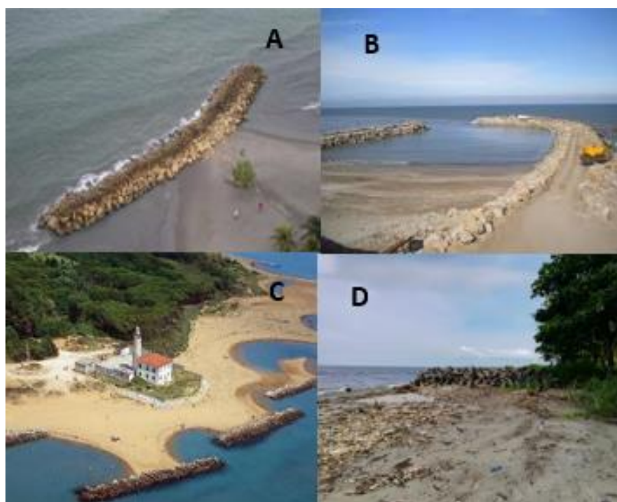
Figura 1. Tipos de obra de protección duras A) D) Dique exento B) Espigón C) Espolón, Fuente: Tomado de Invemar (A, B, D) y sites.google.com (D).
