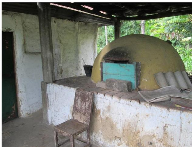
Foto 3. Horno en iglú de leña en la cocina de “la casa vieja”. Horno en iglú de leña en la cocina de “la casa vieja” de la finca la Guacamaya febrero de 2013, el horno fue reconstruido porque el “original” se derrumbó en el año 2012
