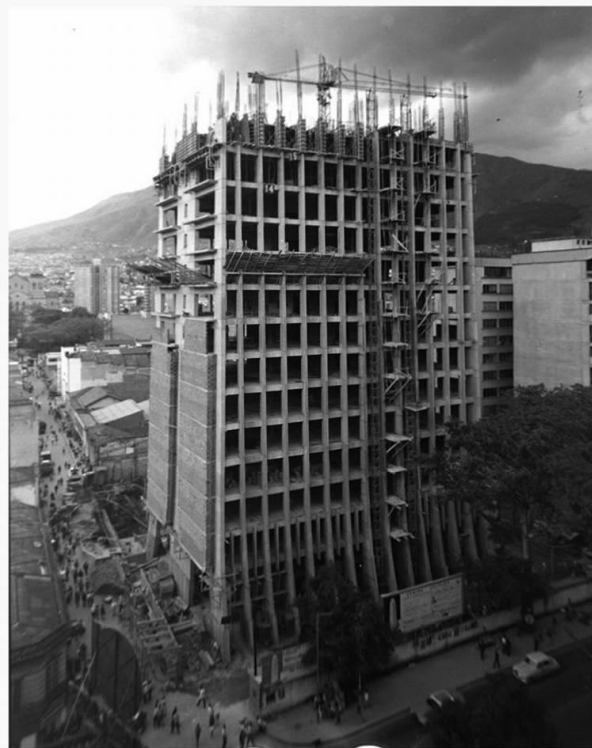
Imagen 6 Medellín, 1968. Construcción del Edificio Coltejer 90
