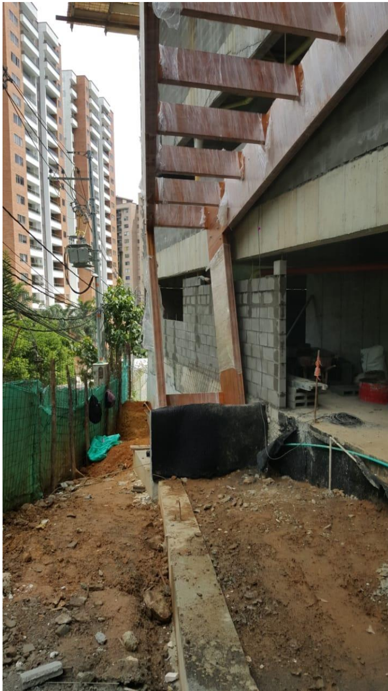
Figura 8. Construcción portería obra Mocaccino.
