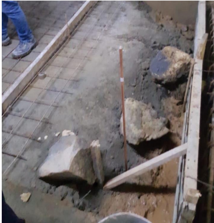
Figura 7. Instalación de varilla copperweld en sótano 3 para SPT.
