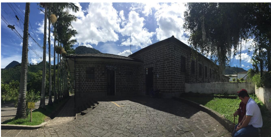
Ilustración 11. Hospital Gabriel Peláez Montoya. Fuente: Registro fotográfico personal.
