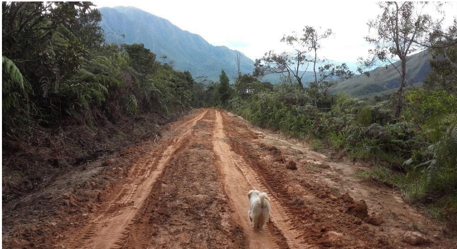
Imagen 2. Estado de la vía sector El Taladro. (Autor: Carlos Rosales)
