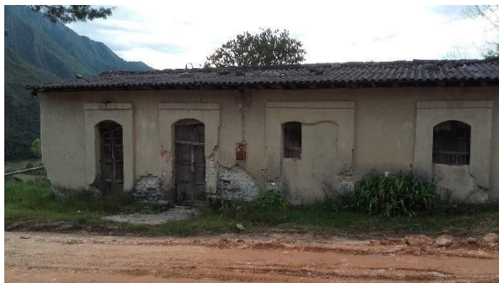
Imagen 5. Casa abandonada - Sector El taladro. (Autor: Carlos Rosales)
