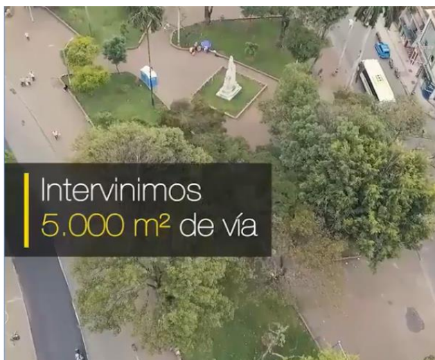
Figura 36. Intervención de vías
