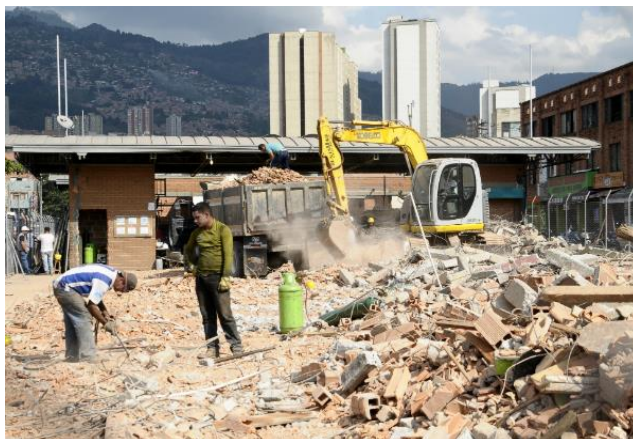
Figura 5. Demolición de los Puentes
