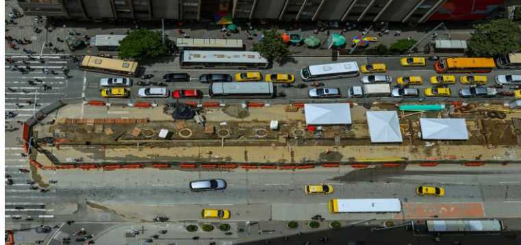
Figura 2. Eco estación Av. Oriental
