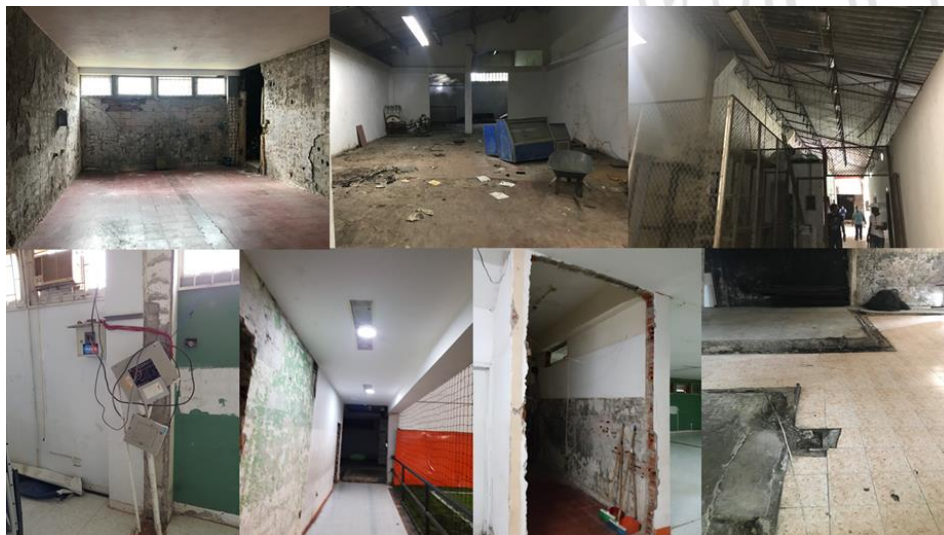
Foto 6. Estado infraestructura 1.8 y 1.9, en los sectores de demolición
