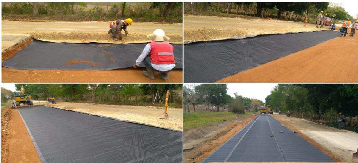
Imagen 6. Instalación del geosintético LAMIDREN L7 en campo. Fuente: Elaboración propia.
