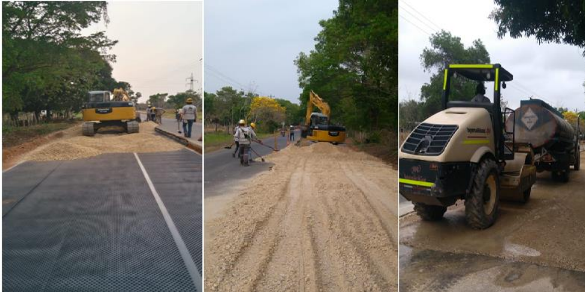
Imagen 7. Adicción y compactación de la base granular sobre el LAMIDREN L7. Fuente: Elaboración propia.
