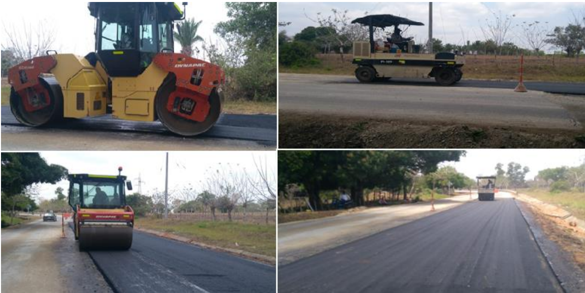
Imagen 10. Compactación de la carpeta asfáltica. Fuente: elaboración propia.
