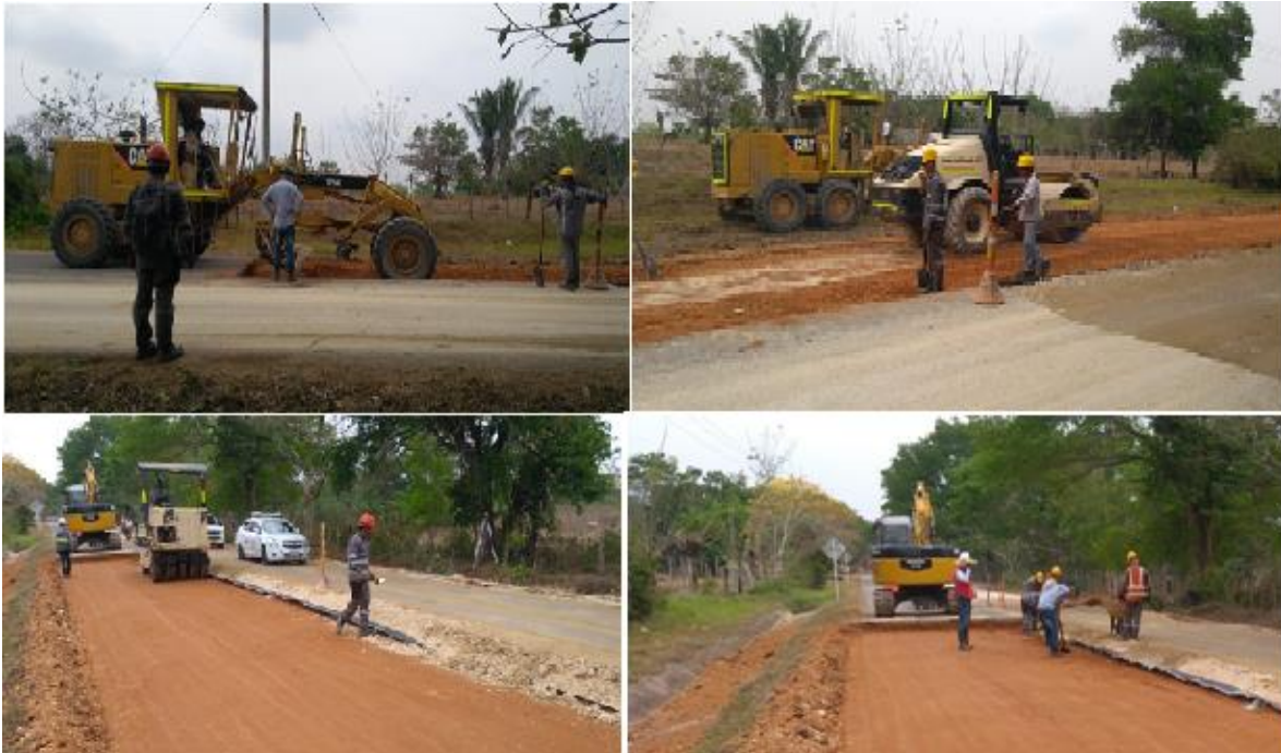
Imagen 5. Compactación del terreno para el primer tramo. Fuente: Elaboración propia.
