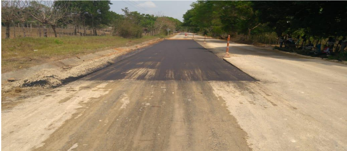
Imagen 11. Finalización del proceso de pavimentación para el primer tramo. Fuente: elaboración propia.
