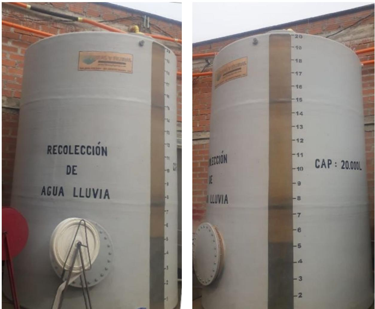
**Figura 5.1.1.** Sistema de captación de aguas lluvias dentro de Avícola San Martín S.A. (ubicado en la granja de producción)
