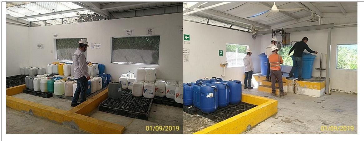
Ilustración 13. Dique de contención frente de Campamentos.
