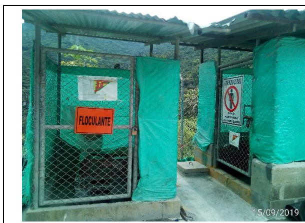
Ilustración 11. Dique de almacenamiento en el Acopio de residuos.
