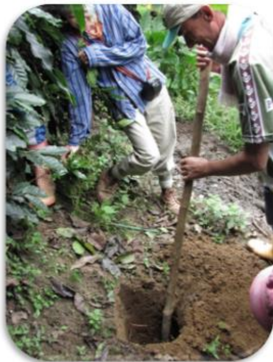
Fotografía 3 Construcción de los pozos sépticos
