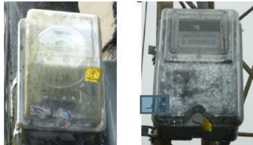
Fig. 16. hallazgo de incumplimiento en el grado de protección IP. Tomado de [9].
