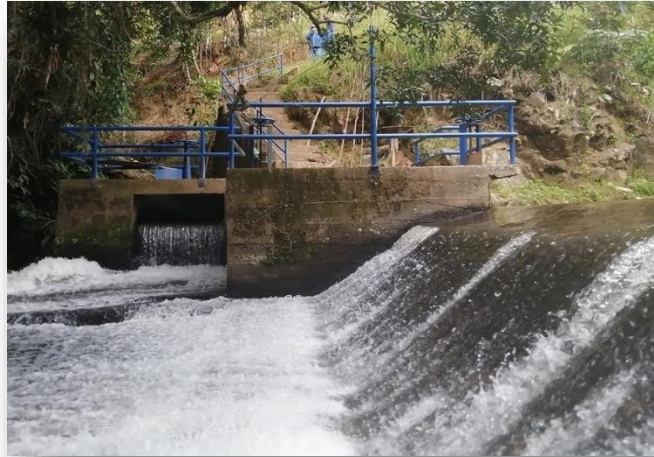
Figura 3. Vista lateral de la Bocatoma del acueducto del municipio de San Sebastián de Mariquita. (Fuente: Autor)
