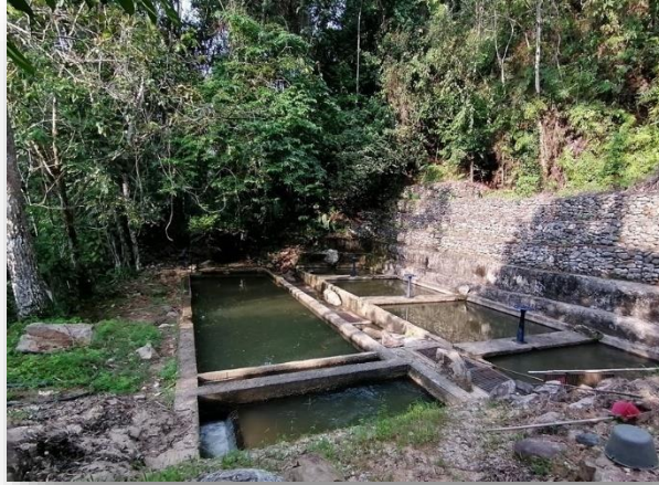
Figura 5. Vista 2 de los desarenadores del acueducto de San Sebastián de Mariquita. (Fuente: Autor)
