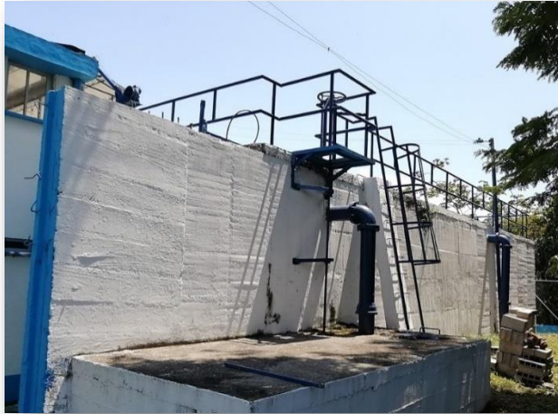
Figura 14. Vista lateral del tanque de almacenamiento N° 1 del acueducto del municipio de San Sebastián de Mariquita. (Fuente: Autor)
