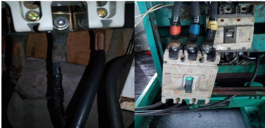
**Figura 22.** Sobrecarga de conductores.
