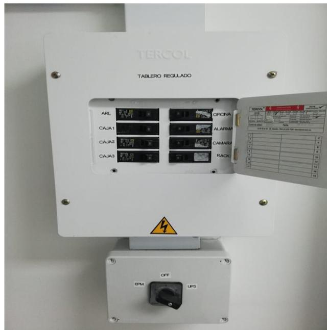
**Figura 28. Sistema Bypass y tablero regulado.**
