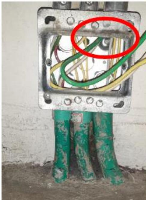
*Figura 6 Caja metálica sin cable de tierra.*
