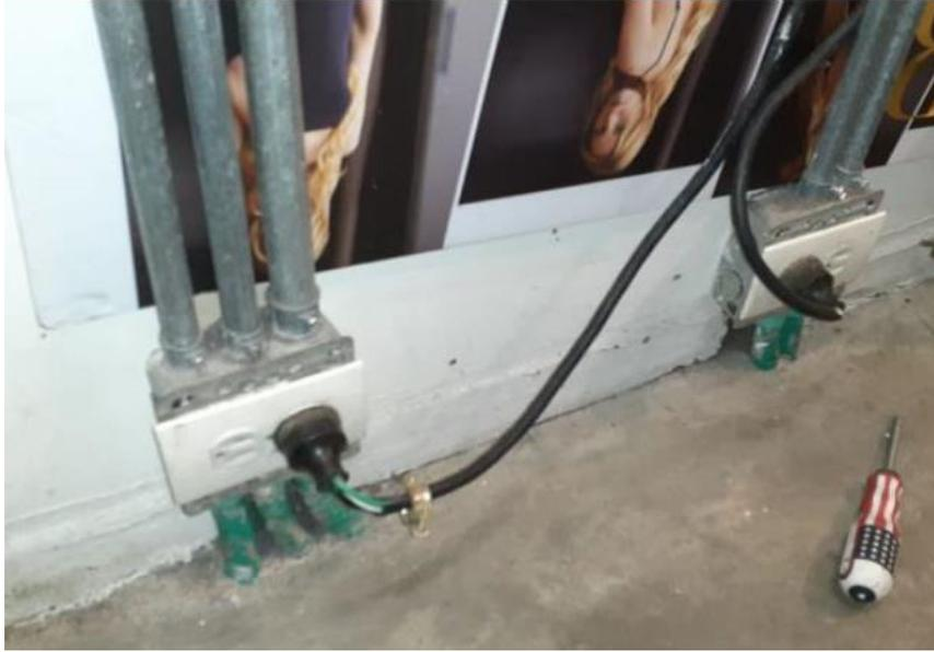
*Figura 5 Tubería expuesta y sin marcación.*
