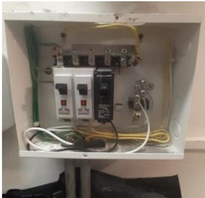
*Figura 10 Breaker de 15 A con cable calibre 12AWG.*
