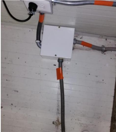
*Figura 50 Marcación de tubería EMT con franja naranja.*
