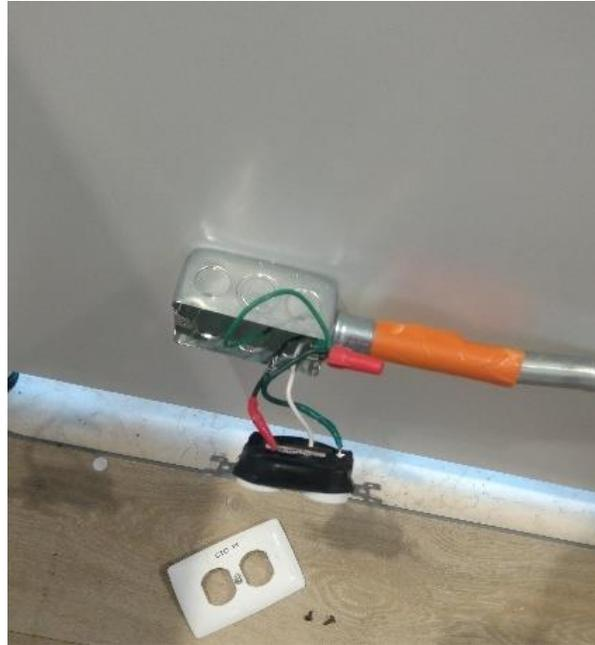
*Figura 19 Toma con tierra, fase marcada y tubería con señalización.*
