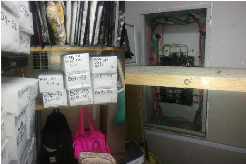
*Figura 23 Tablero de protecciones obstruido Touché Mall Plaza.*
