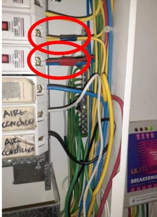
Figura 11 Breaker con dos cables de salida.
