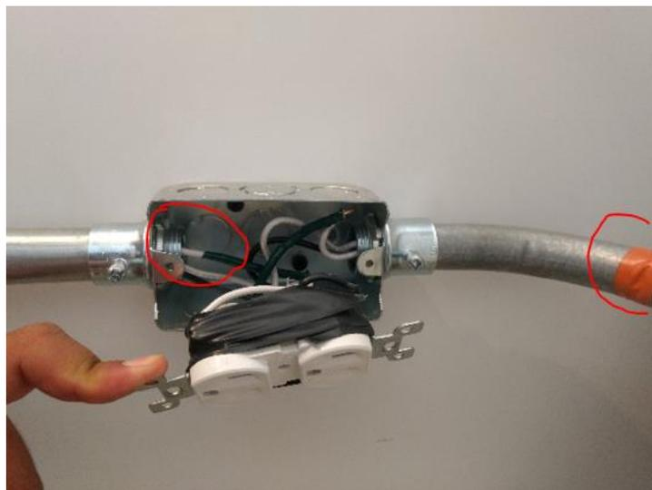
Figura 18 Toma con tierra suelta, fase sin marcar y tubería sin señalización.
