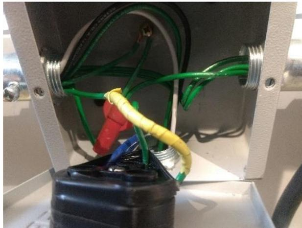
*Figura 20 Caja metálica aterrizada y marcación de fases.*
