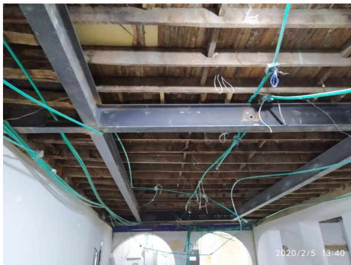
Imagen 5. Condiciones del local al empezar la obra.
