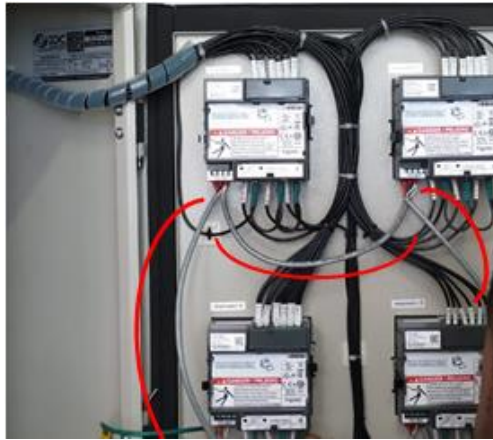
Imagen 11. Conexión de analizadores en serie.
