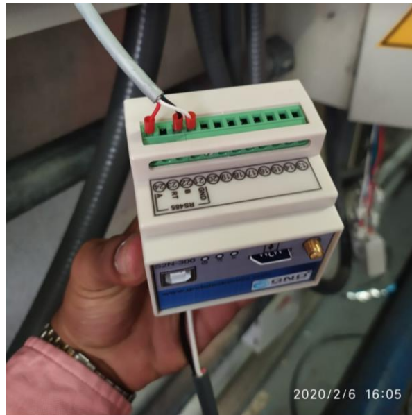
Imagen 12. Conexión de señales de analizadores al Gateway.
